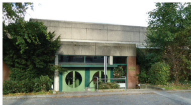
Sporthalle Kuhlo-Realschule · Ehlenruper Weg
